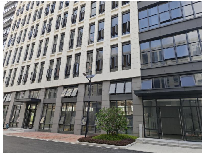
项目西侧为其他未装修施工厂房
