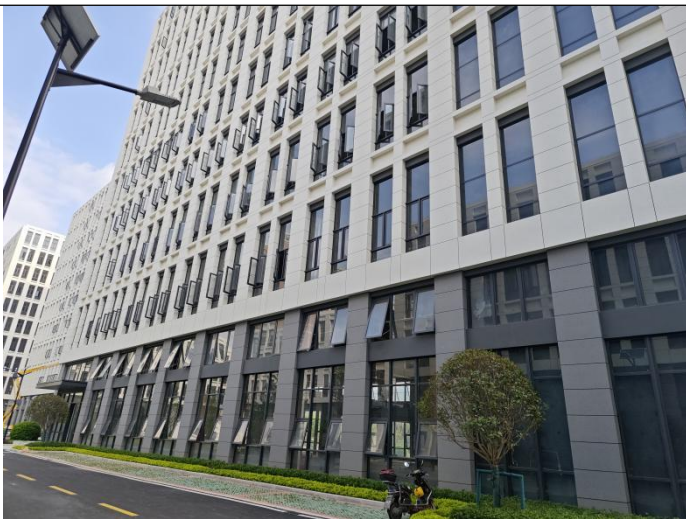
项目北侧为其他未装修施工厂房
