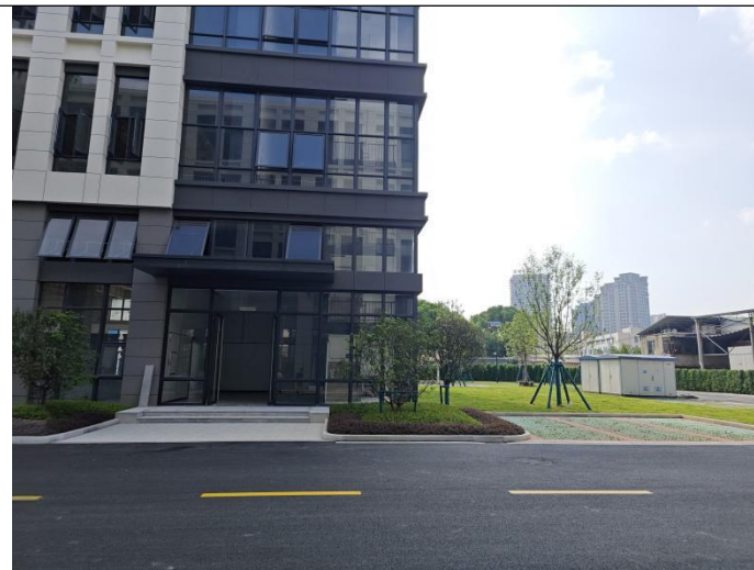
项目东侧为其他未装修施工厂房
